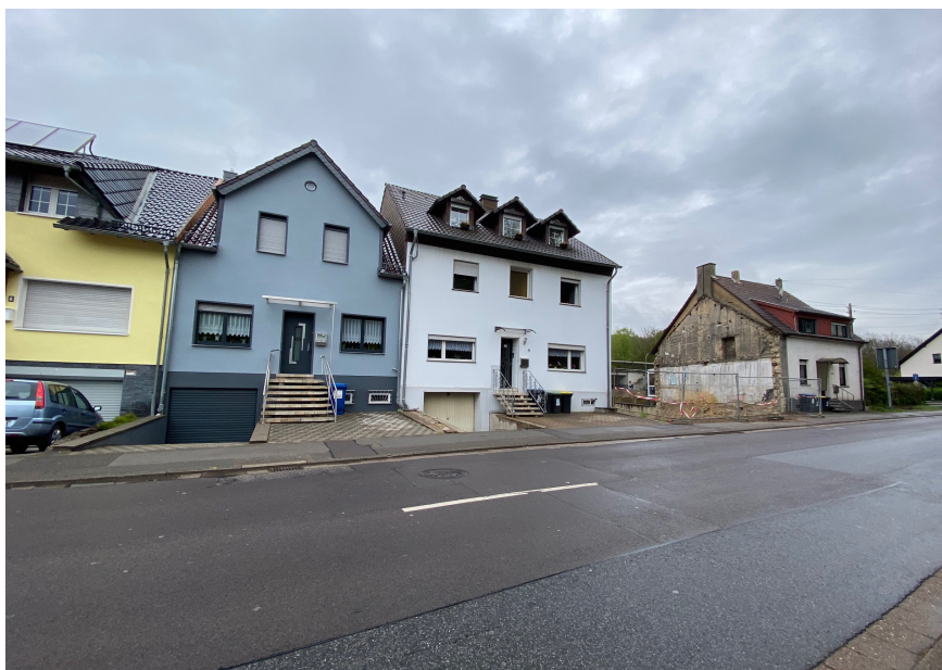
Blick auf das Plangebiet und die bestehende Bebauung aus westlicher Richtung
