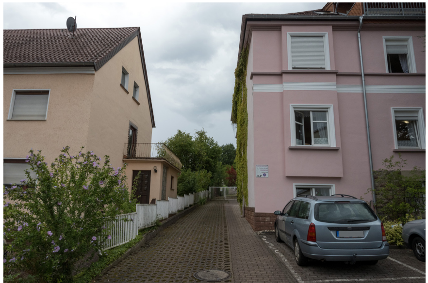
Blick auf den Bereich der geplanten baulichen Verbindung zwischen Seniorenheim „Haus im Warndt“ und geplanter Erweiterung (anstelle des aktuell noch bestehenden Wohngebäudes links)
